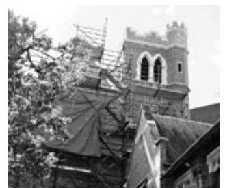
修復工事が行なわれているセント・ジョージズ大聖堂
