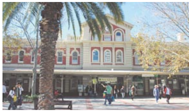
駅周辺は、都市開発に関連して各所が工事中となっている(2014年8月現在)。
